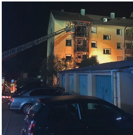
Im Bereich des Daches brannte es ebenfalls.
