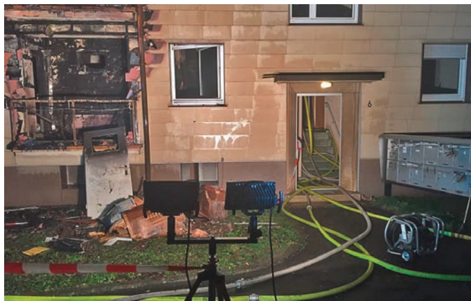
Die Brandbekämpfung von innen erfolgte durch das Treppenhaus.
